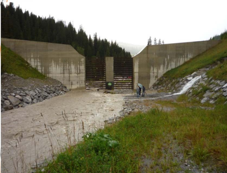
Alpenhochwasser Aug. 2005, Lech a.A. – vorbeugender baulicher HW-Schutz
