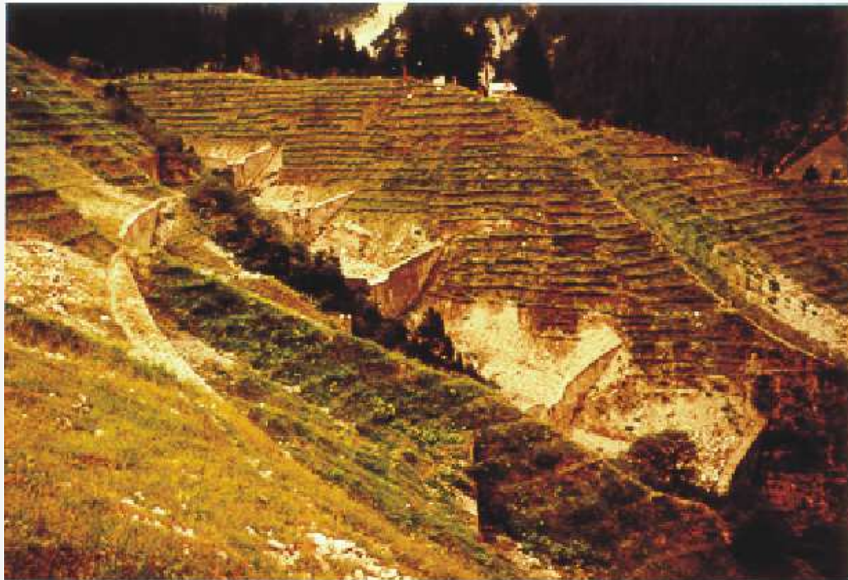
Filpitterrüfe – Konsolidierungssperren und Weidencordons
