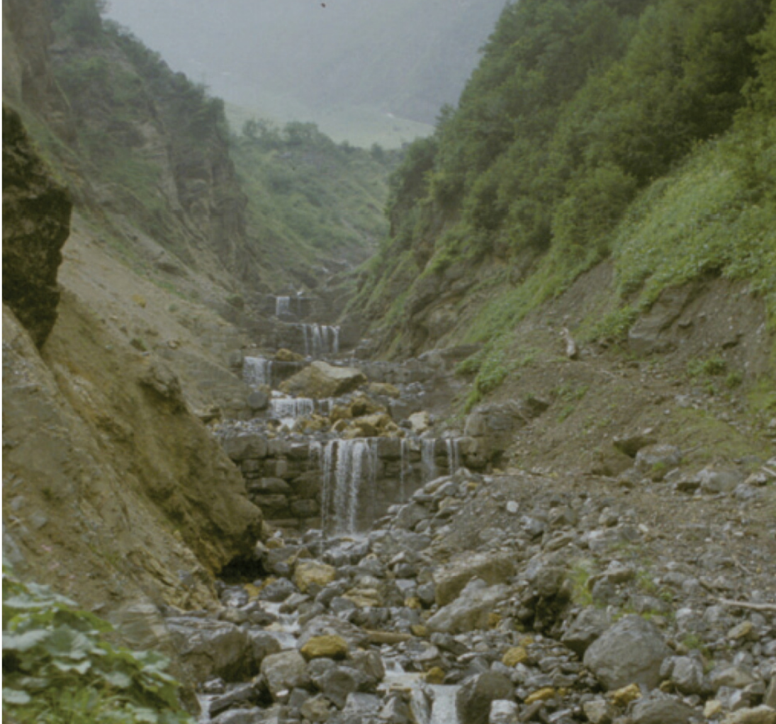
Sperrentreppe im Siententobel
