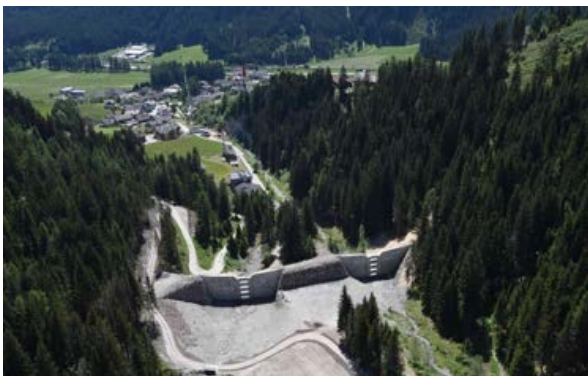
Slika 14: Zadrževalni jezovi – Winnebach, Južna Tirolska (©Avtonomna pokrajina Bolzano/Bozen, Agencija za civilno zaščito)
