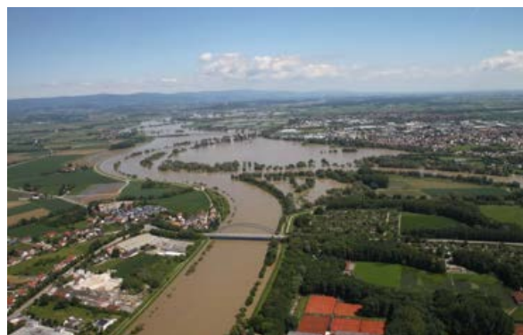
Figura 15: Interventi strutturali di protezione e contenimento in Baviera (©Agenzia bavarese per l'ambiente)
