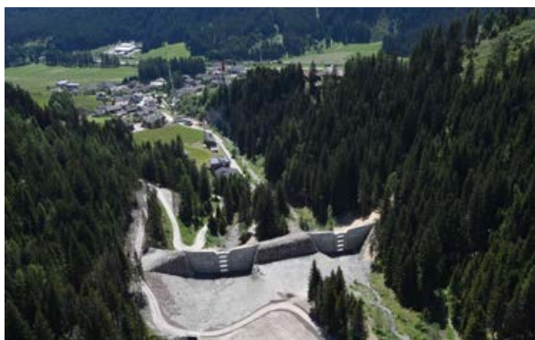
Figura 14: Briglie fluviali, Prato alla Drava, Alto Adige (©Provincia autonoma di Bolzano/Bozen, Agenzia per la protezione civile)
