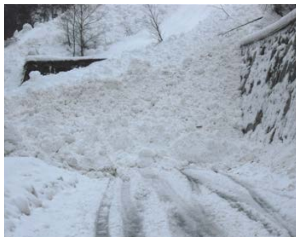
Figura 47: Esempio di area di deposito che ostruisce l'ingresso in galleria (©Regione Autonoma Valle d'Aosta)
