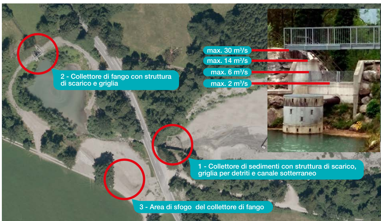
Figura 49: Panoramica dettagliata delle diverse strutture tecniche di un torrente (©Ufficio della protezione civile, Liechtenstein)
