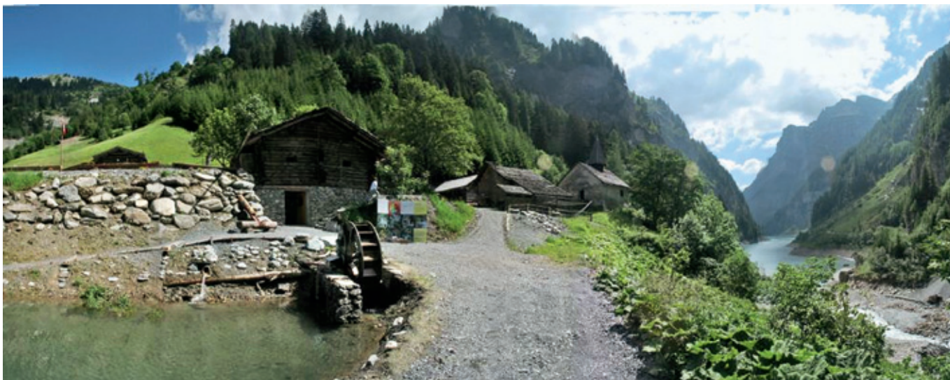
Slika 5: Sv. Martin, naselje v Alpah (Kanton Graubünden, Švica) brez povezave z javnim električnim omrežjem. Proizvodnja elektrike z malo hidroelektrarno. © Program Kleinwasserkraftwerke 16
