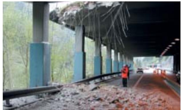
Durch Steinschlag beschädigte Schutzgalerie in der Nähe von Gurtellen, Kanton Uri (April 2003). Quelle: Amt für Tiefbau Kanton Uri, Altdorf
