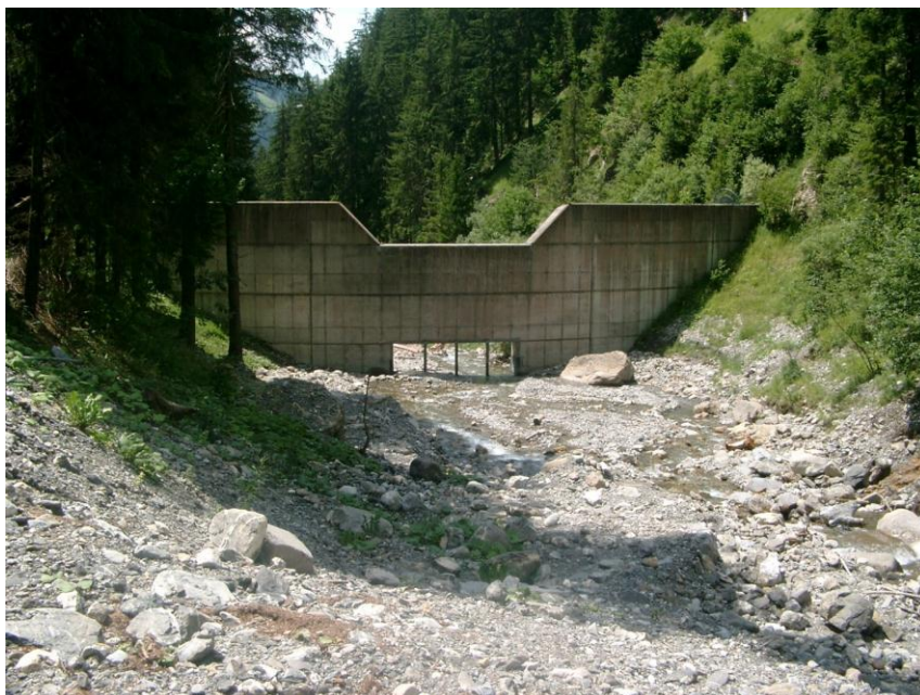
Bisherige Bogensperre, Rückhaltebecken Betelriedgraben
