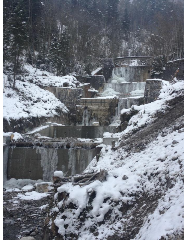
Situation nach der Sanierung Quelle: BAFU
