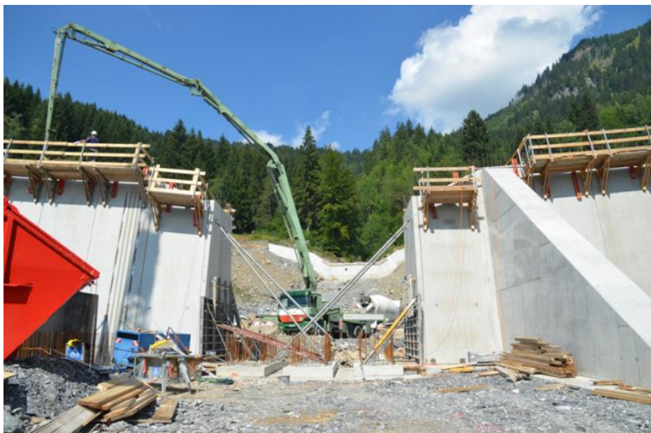
Abb. 10: Bauausführung der Murfangsperr im Zillenbach, Gemeinde Hindelang, Oberallgäu (Foto: WWA Kempten).
