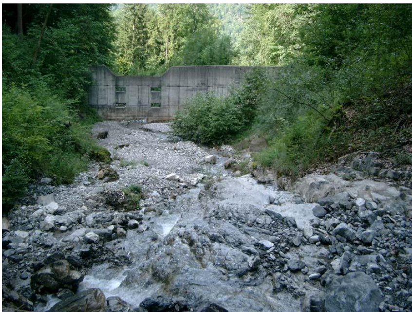
Rückhaltebecken vor Modifizierung
