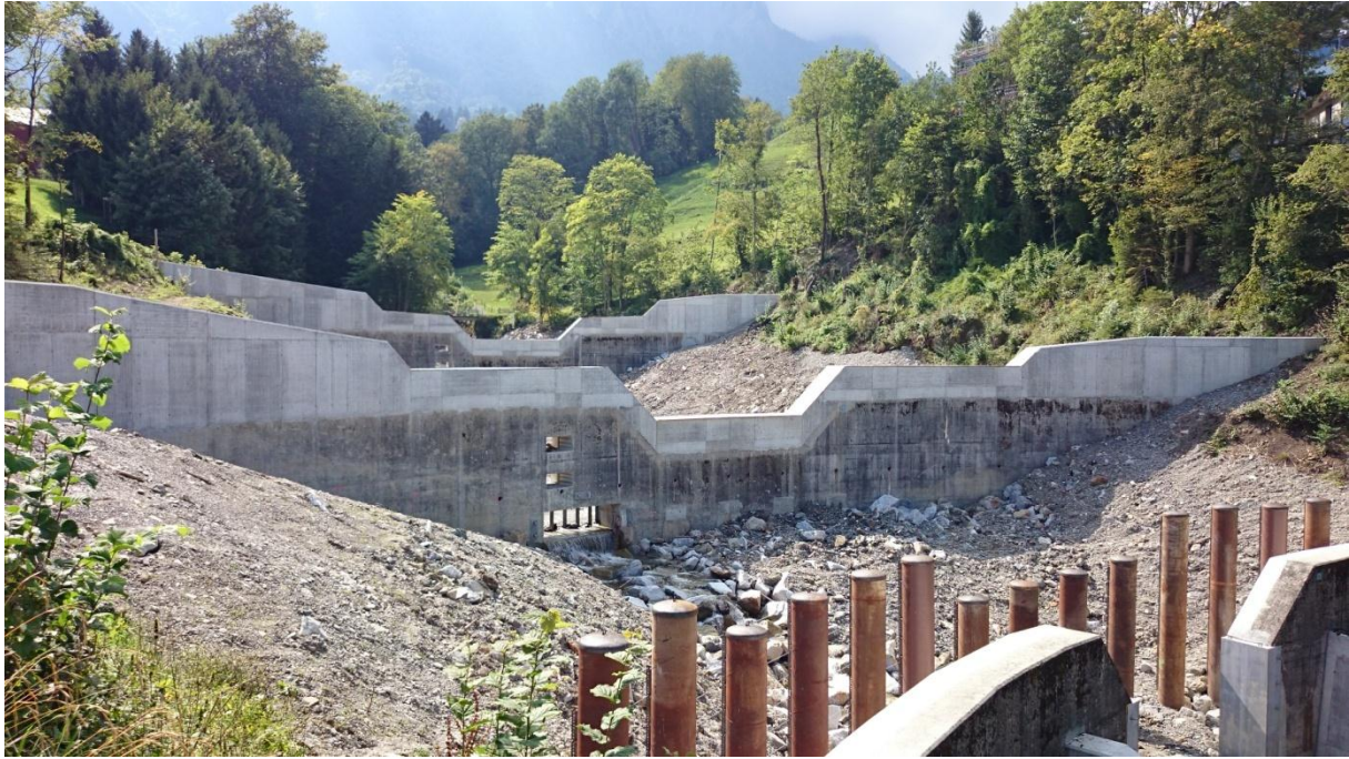
Blick auf die fertiggestellte Konstruktion
