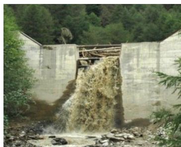
Abb. 21: Gadriabach: Einzelheiten der Blockierungsmechanismen (d.h. durch Treibholz und Feststoffe) in den Sperrenöffnungen und die daraus resultierende Aufschüttung des Rückhaltebeckens.
