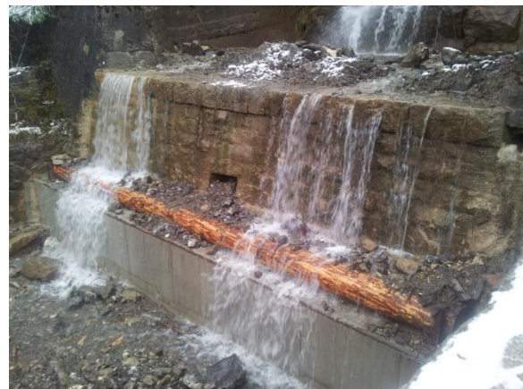
Fertiggestellte Vorbetonierung und Holzabdeckung Quelle: Kanton NW
