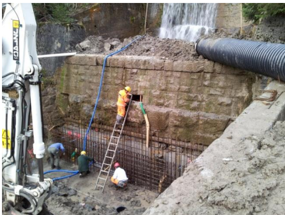
Vorbetonierung Quelle: Kanton NW
