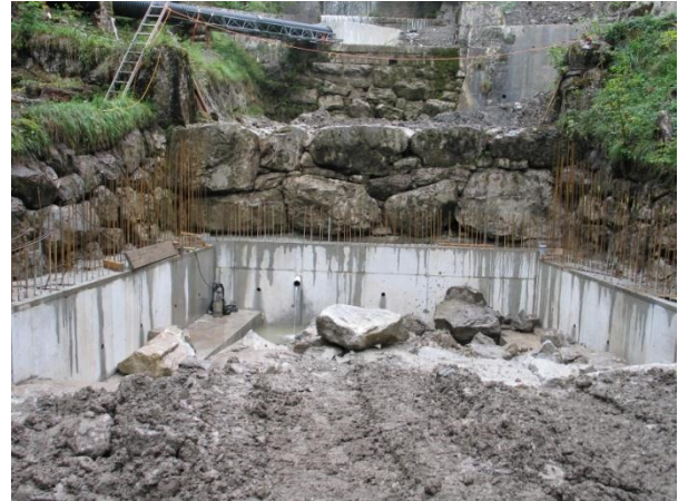
Vorbetonierungs- und Leitwerke
