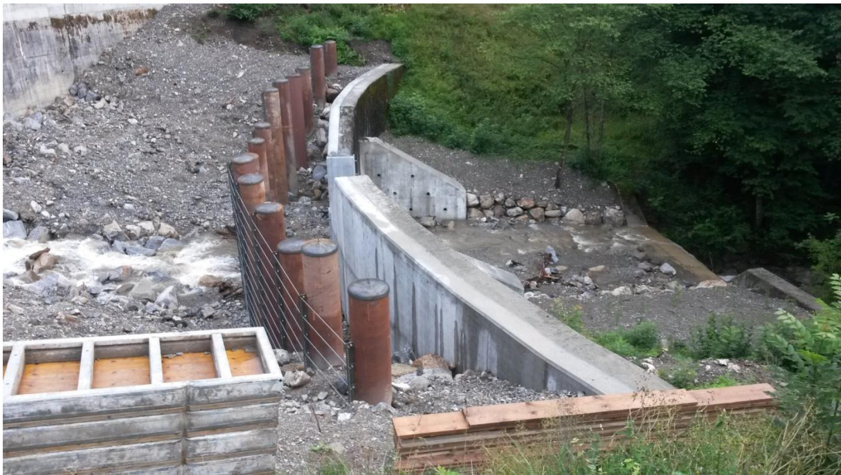
Modifizierung von Bogendamm 3 zur Rückhaltung von Wildholz
