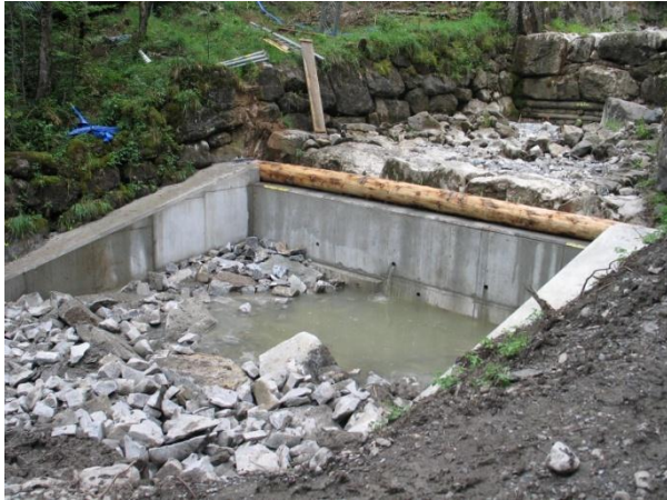
Bau eines Ersatzdammes
