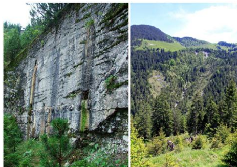
Abb. 16: Historische Schutzbauwerke und aufgeforstete Erosionsgebiete im Galina-Einzugsgebiet (Vorarlberg).
