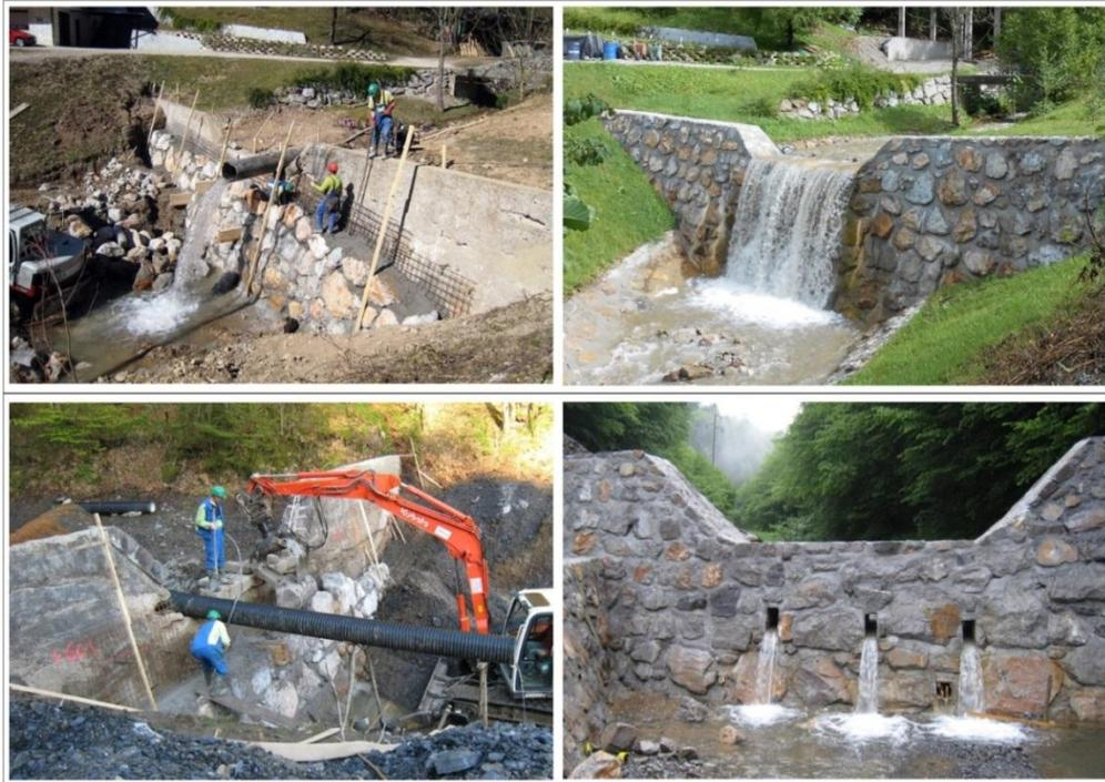
Eine Lösung zur Instandhaltung der Funktionsfähigkeit altersschwacher Sperren ist die Errichtung von massiven Stützbauten aus Stein, die mit den bestehenden Bauwerken verankert und verbunden werden und so zu einem Objekt verschmelzen (zwei Beispiele aus den Wildbächen Mačkov graben und Prošca, Foto: Hidrotehnik, Slowenien)
