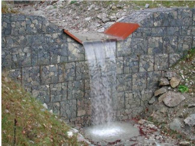
Gabionen können aufgrund von Abnutzung insbesondere im Abflussbereich leicht zerstört werden. Aus diesem Grund wurden einfach zu ersetzende Stahlplatten installiert, um den stark beanspruchten Teil der Wildbachsperre zu sichern. Beispiel Talgraben, Lkr. Bad Tölz-Wolfratshausen, Bayern
