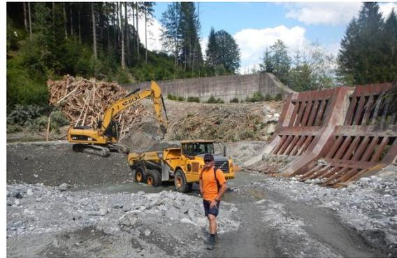
Abb. 9: Der Betrieb kann ebenfalls einen hohen Aufwand bedeuten. So müssen Rückhaltebecken zum Beispiel regelmäßig ausgeräumt werden.
