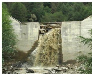
**Abb. 21:** Gadriabach: Einzelheiten der Blockierungsmechanismen (d.h. durch Treibholz und Feststoffe) in den Sperröffnungen und die daraus resultierende Aufschüttung des Rückhaltebeckens.
