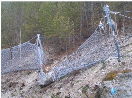
Abb. 11: Die Überwachung ist notwendig, um den Instandhaltungsbedarf zu ermitteln und damit die kontinuierliche Funktionsfähigkeit zu gewährleisten.
