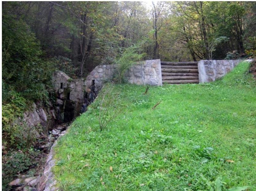
Neue Randbedingungen erfordern die Funktionserweiterung der bestehenden Schutzbauten - eine übliche Maßnahme ist die Erhöhung der Schutzsperren. Auf dem Foto sieht man ein solches Beispiel aus dem Wildbach Lučno: das Bauwerk wurde durch einen Zugang für Besitzer erweitert (mit beweglichen Holzstämmen), die in regelmäßigen Abständen Holz aus den bewaldeten Quellgebieten ausräumen müssen (Foto: Hidrotehnik, Slowenien)
