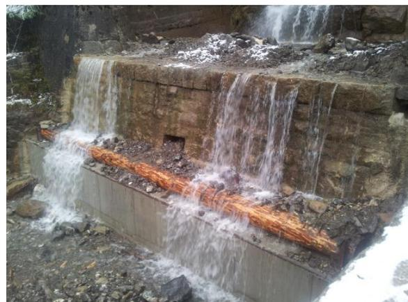
Fertiggestellte Vorbetonierung und Holzabdeckung
