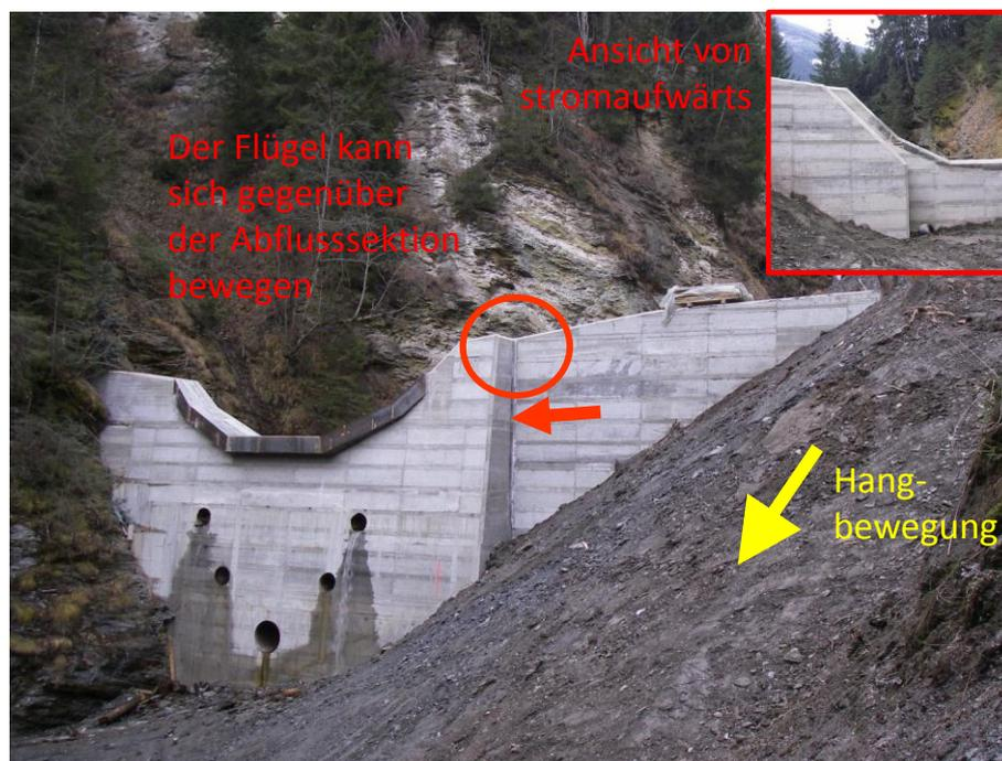
Rückhaltesperre mit verschiebbarem Flügel zum Ausgleich von seitlichem Gebirgsdruck,
