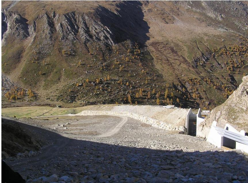
Auslaufsperr (rechts), Rechensperre (links von der Auslaufsperr) und Ablagerungsgebiet (links)
