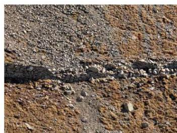
Abb. 26: Rückgebaute Steinmauer gegen Lawinen.
