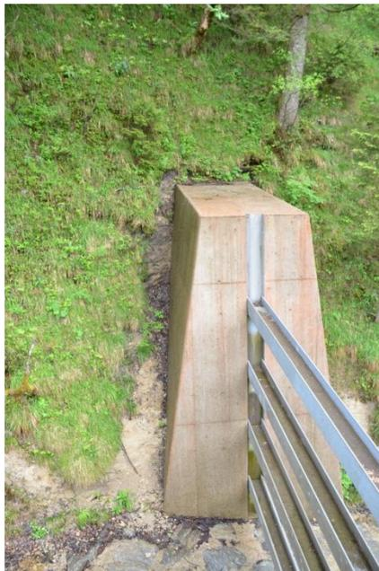
Der vertikale Abstand der Stahlträger in diesem Rückhaltedamm kann ohne Weiteres verändert werden. Auf diese Weise kann das Bauwerk zukünftig den Umständen angepasst werden, ohne dass es neu errichtet werden muss. Beispiel Maigraben, Lkr. Rosenheim, Bayern
