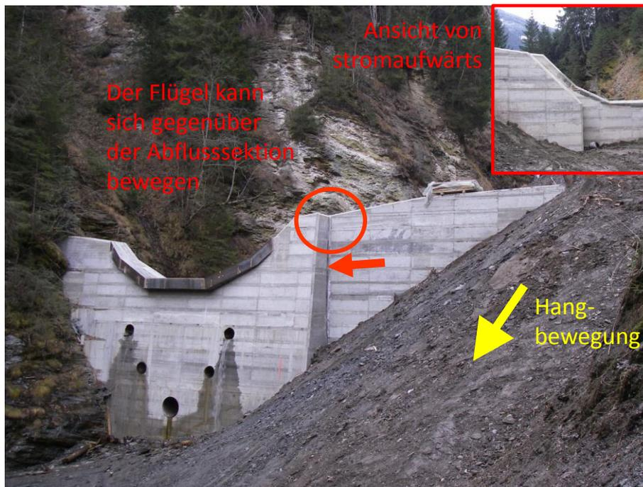
Rückhaltesperre mit verschiebbarem Flügel zum Ausgleich von seitlichem Gebirgsdruck,
