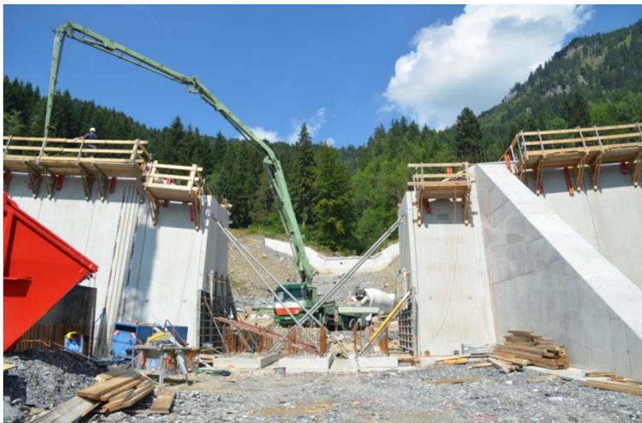
Abb. 10: Bauausführung der Murfangsperrung im Zillenbach, Gemeinde Hindelang, Oberallgäu (Foto: WWA Kempten).
